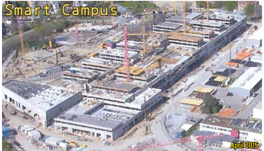
Eindrucksvoll zeigen die beiden Bilder den Baufortschritt am Smart Campus.
