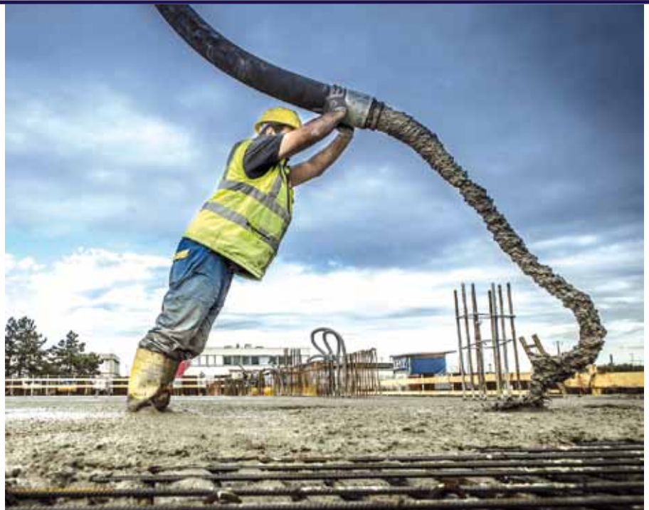
Arbeiten wie diese sind vorbei - jetzt geht es mit dem Innenausbau weiter.
