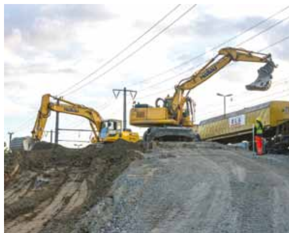
Die Aushubarbeiten gehen dem Ende zu
