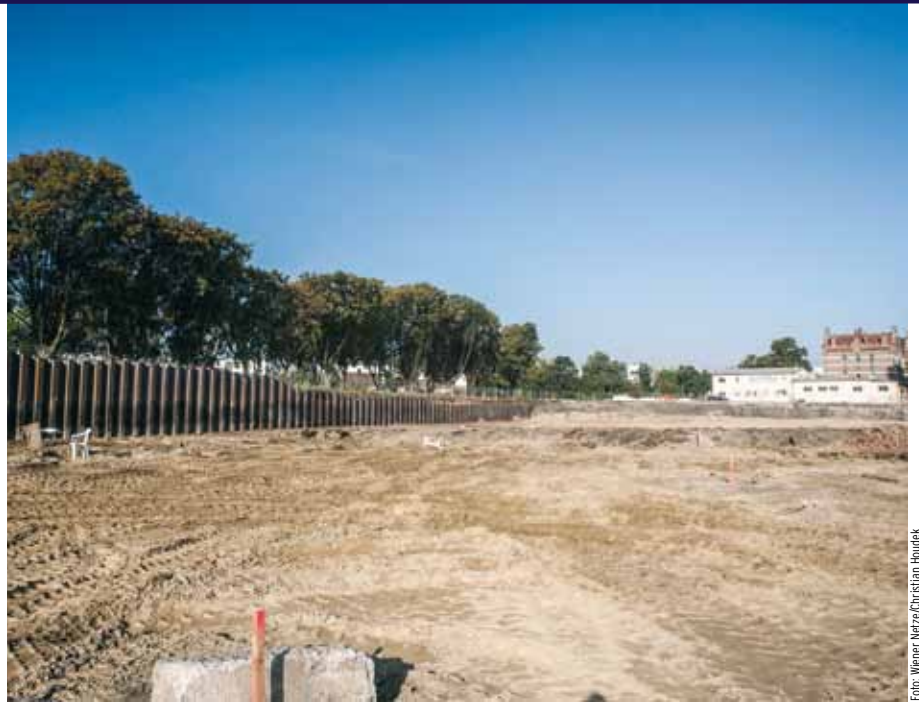
Die Bäume der Nussbaumallee werden die Errichtung des Smart Campus unbeschadet überstehen. Vor der Baumreihe sind die Spundwände zur Sicherung der Baustelle zu sehen
