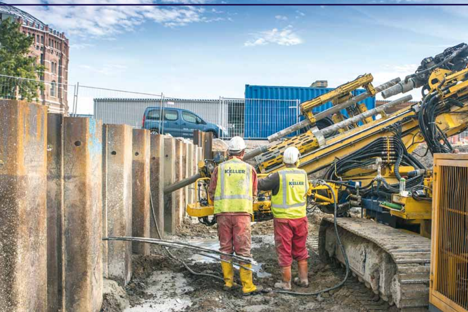
Hier werden noch die Spundwände fixiert, aber bald werden die Gerätschaften neuen Maschinen Platz machen und der Hochbau kann beginnen
