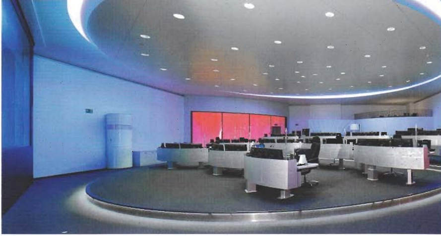
Um störende Spiegelungen auf der Videowand zu vermeiden, wurde das runde Deckenelement des Kontrollraums mit einer Neigung von 15 Grad montiert, wobei die Leuchten weiterhin im 90-Grad-Winkel nach unten strahlen.
