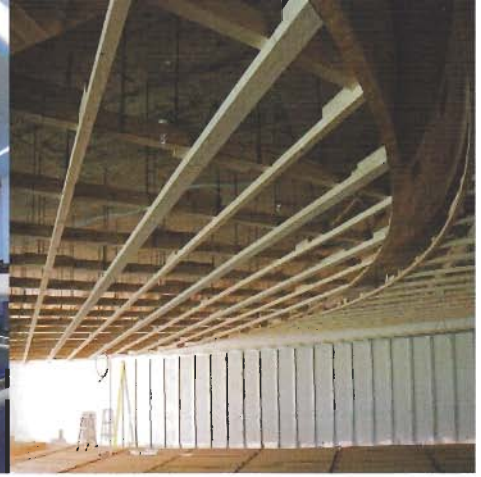
Das Deckenelement während der Bauphase
