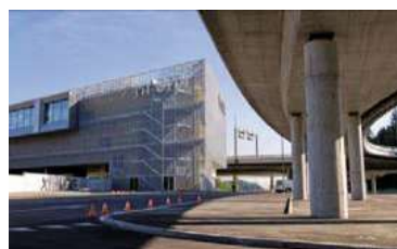
Raststätte Knonaeramt (Brücken + Hochbau)
