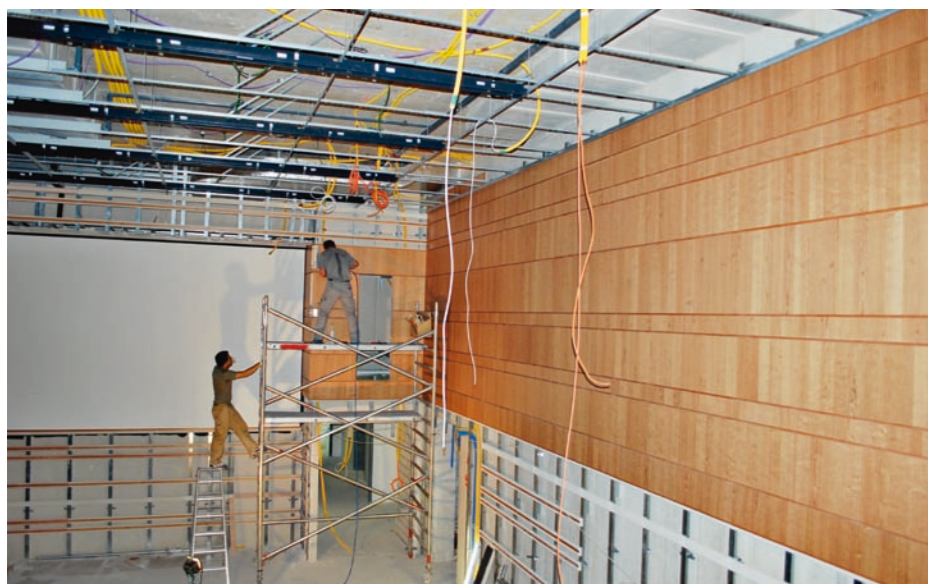
Oben: Arbeiter kleiden mit Holzwerkstoffplatten, die mit Black-Cherry-Holz furniert sind, den Raum aus. Visualisierung unten: Im grossen Hörsaal im Hauptgebäude finden 400 Personen Platz.
