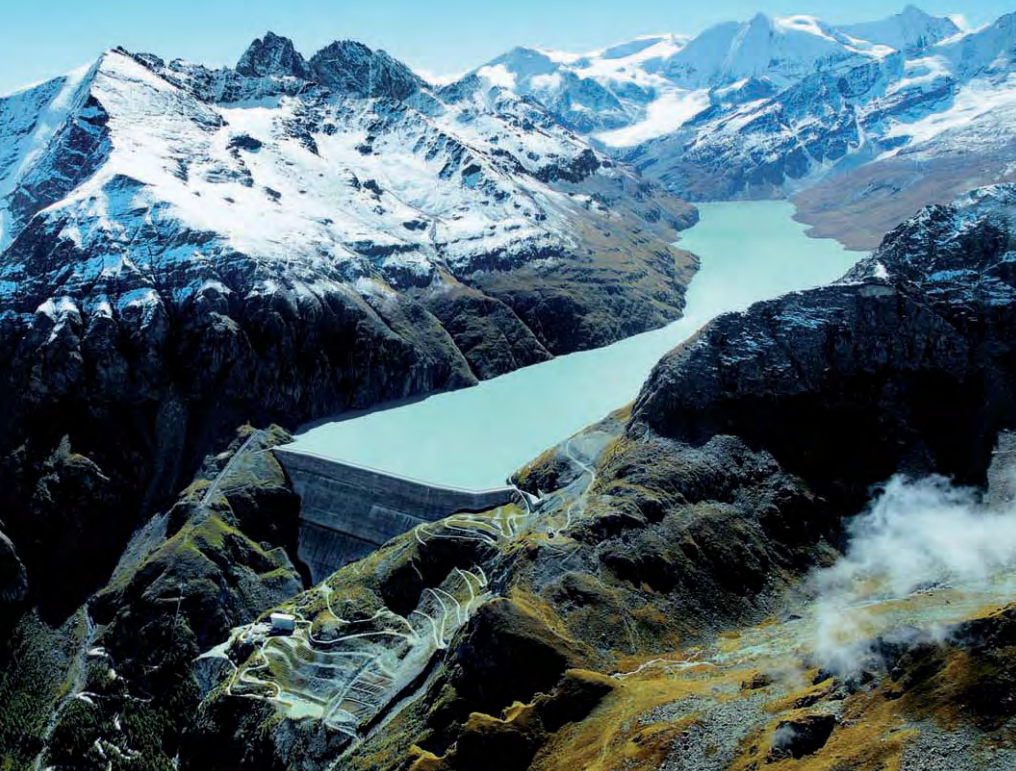
Die Batterie: Schweizer Pumpspeicherkraftwerke, hier Grande Dixence, sollen Europas Stromversorgung stützen.
